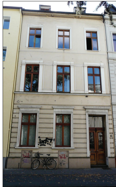
Mit DIG-CAD können fotografierte Bilder in Zeichnungen integriert werden. Mithilfe der fotogrammetrischen Entzerrung lässt sich so z.B. das Aufmaß schwer zugänglicher Fassaden erstellen.
